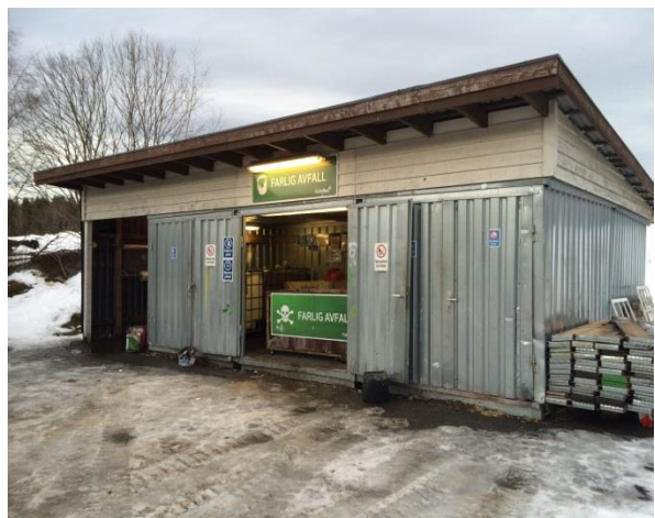
Farlig Avfall bygg Teigen
